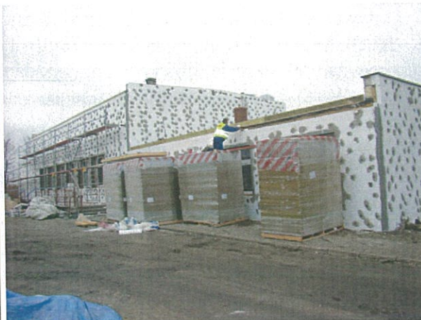
Prace remontowe przy świetlicy w Szczuce
