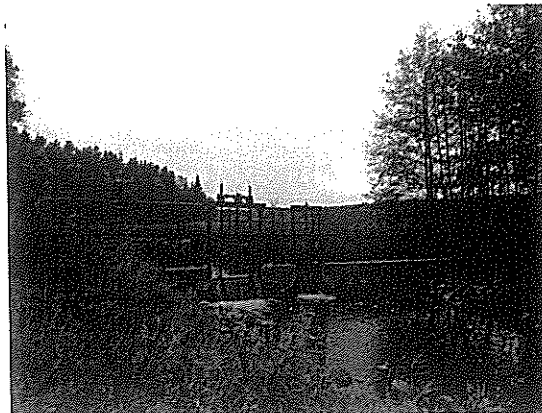
Fot. 24. Przepust wodny Źródło: zdjęcie własne
