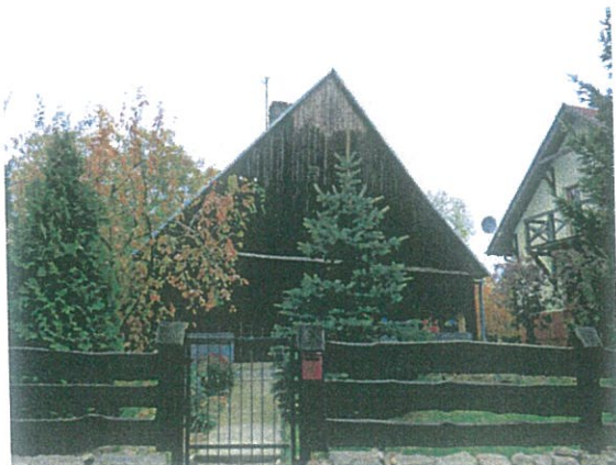
Fot. 21. Chata podcieniowa
