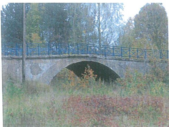
Fot. 13. Most drogowy Źródło: zdjęcie własne
