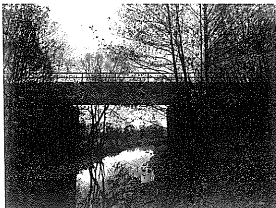
Fot. 23. Most kolejowy Źródło: zdjęcie własne
