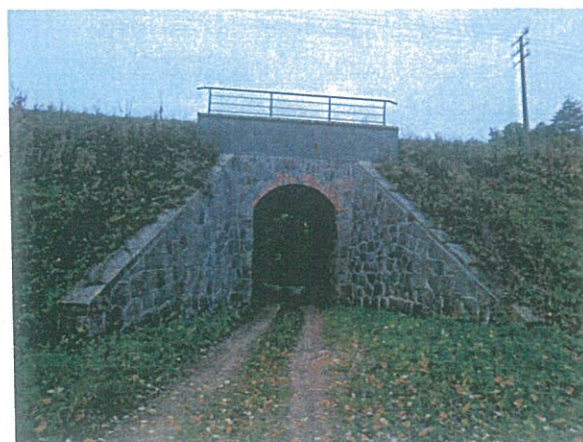
Fot. 14. Wiadukt kolejowy Źródło: zdjęcie własne
