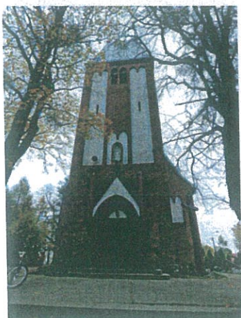
Fot. 15. Kościół p.w. Św. Bartłomieja Źródło: zdjęcie własne
