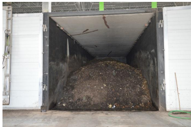
Rysunek 16 Tak jest. Instalacja do stabilizacji i kompostowania - w eksploatacji, Zakurzewo (foto: Zakurzewo, wrzesień 2015r).
