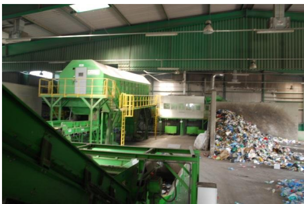
Rysunek 70 Tak było i tak jest. Sortownia odpadów komunalnych zmieszanych i selektywnie zebranych, Toruń MPO (sierpień 2013r)
