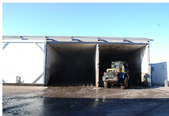
Rysunek 52 Tak Było. Instalacja stabilizacji frakcji biodegradowalnej wydzielonej ze zmieszanych odpadów komunalnych- napełnianie rektorów, Remondis Bydgoszcz (sierpień 2013r)
