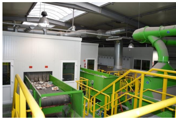
Rysunek 14 Tak jest. Nowa sortownia odpadów (komunalnych zmieszanych i surowcowych), Zakurzewo (foto: Zakurzewo, wrzesień 2015r).
