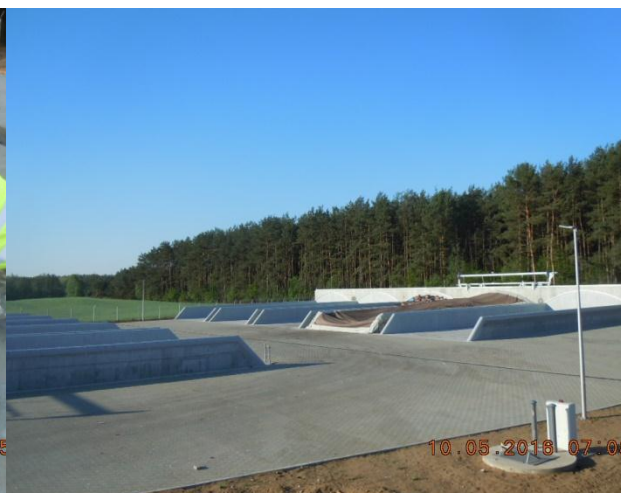
Rysunek 32 Tak jest. Nowa instalacja do biologicznego przetwarzania odpadów z możliwością kompostowania odpadów zielonych, Puszczka Miejska (foto: Puszczka Miejska, marzec 2016r.)
