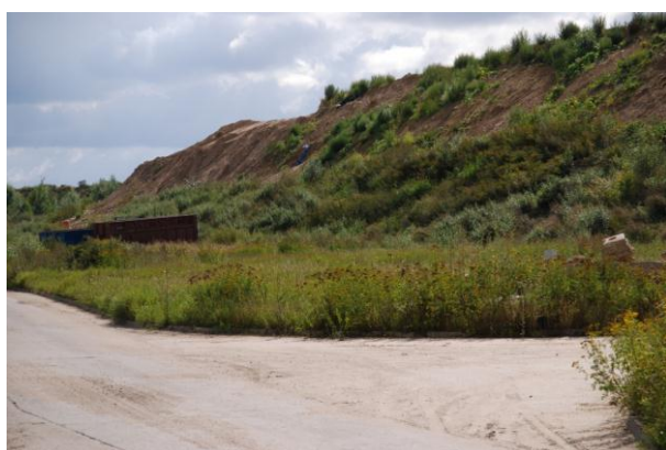
Rysunek 59 Instalacja stabilizacji frakcji biodegradowalnej wydzielonej ze zmieszanych odpadów komunalnych-kopiec BIO-EN-ER, Bydgoszcz ProNatura (sierpień 2013r)
