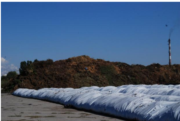
Rysunek 86 Tak było. Instalacja stabilizacji frakcji biodegradowalnej wydzielonej ze zmieszanych odpadów komunalnych, Inowrocław (sierpień 2013r)
