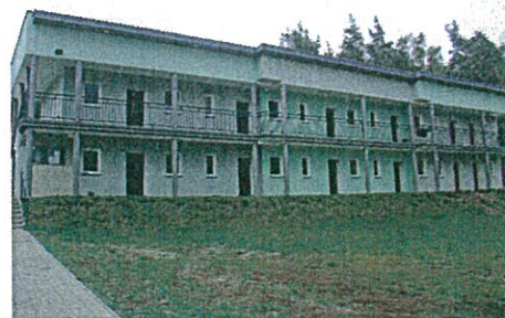
Fot. 3. Budynek socjalny w Kominach Kominy 1A
