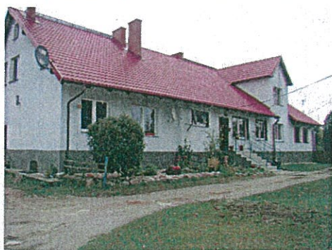
Fot. 2. Budynek komunalny w Moczadłach Moczadła 13
