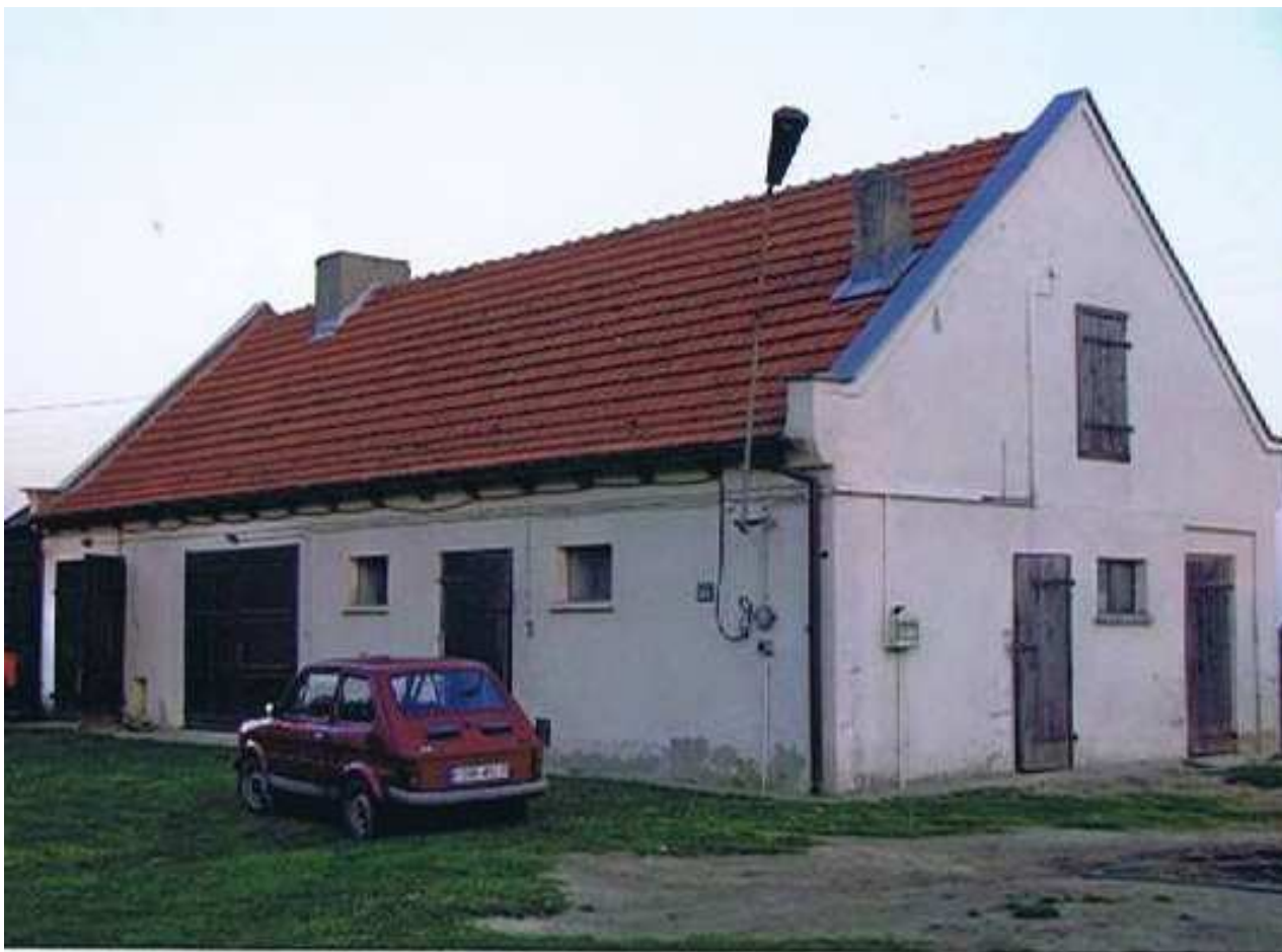
Fotografia od strony podwórza (strona północno – zachodnia)
