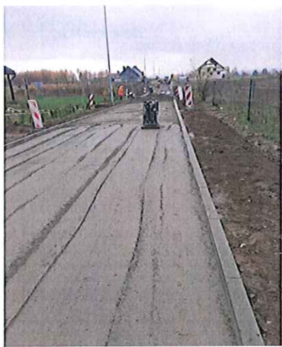
Przebudowa ul. Sezamkowej
