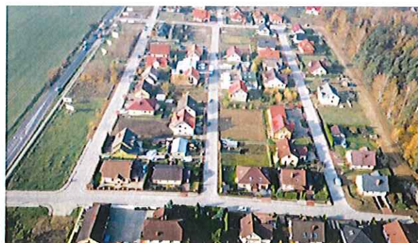
Drogi wybudowane na osiedlu w Cieletach
