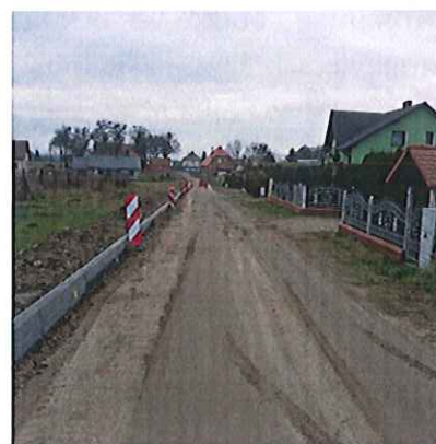
Przebudowa drogi w Gorczenicy
